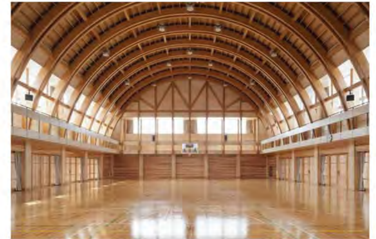
Reference på tennishal i trækonstruktion
